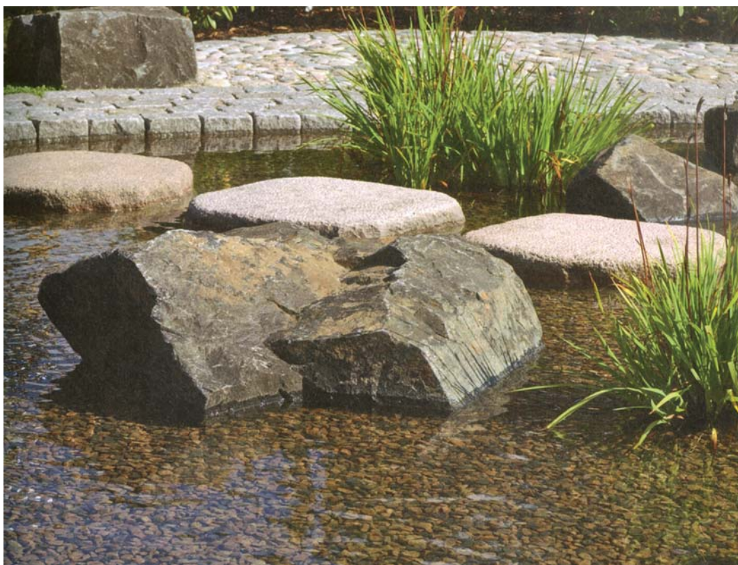
Her er bassinbunden dannet af granitskærver. De lægges løst på et geotekstil eller direkte på gummidugen.
