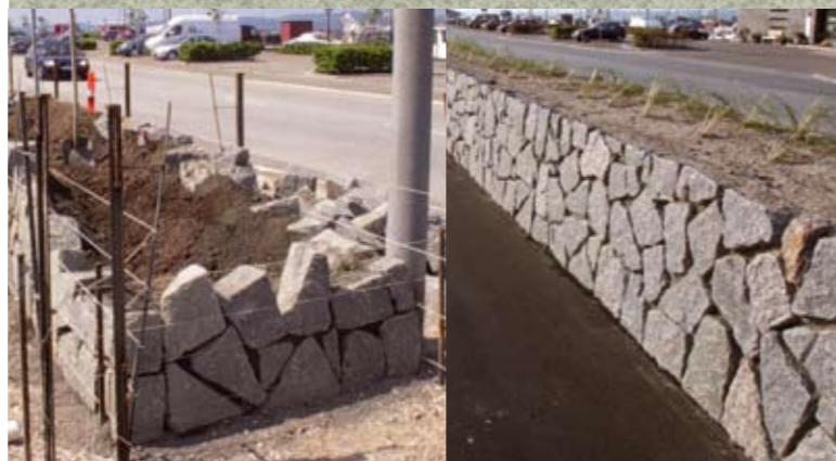
Mur i setzsteine under opbygning
