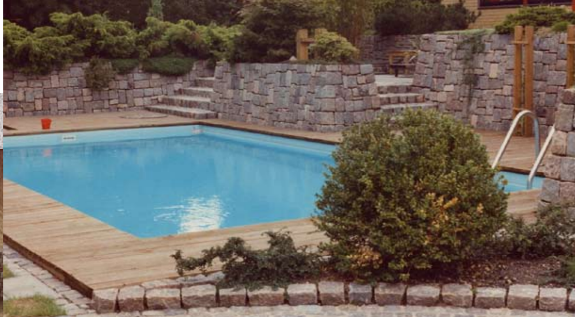
Til venstre og ovenover: Brostensmur i fletmøn- ster i slidte nordiske brosten støbt i beton.
