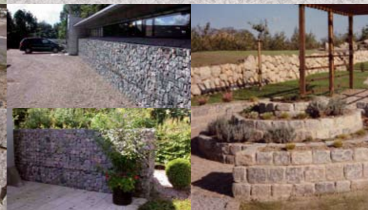
Stenkister (gabioner) fyldt med brudsten
