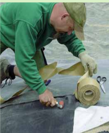
5. En speciel rulle bevæges frem og tilbage ved et konstant tryk på fladerne, således at der sker vedhæftning overalt. For at dette skal lykkes, kræver det et fast underlag.
