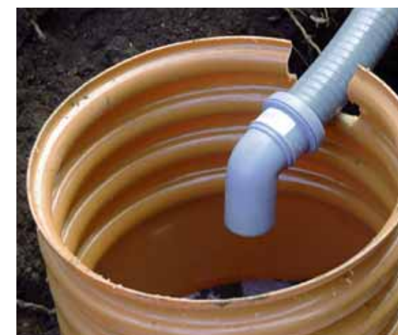
Et korrugeret PVC-rør placeret oven på bioblokken med et eller flere tilløb fra biofiltret.
