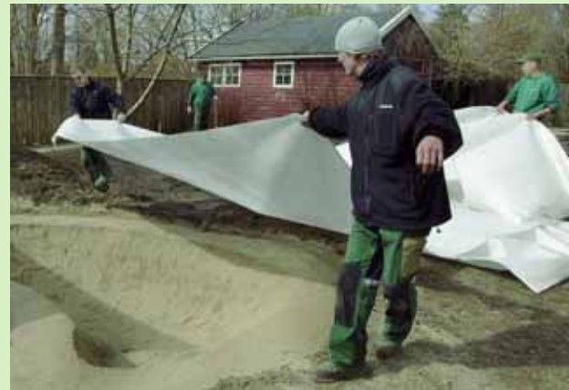
6. Det beskyttende lag af geotekstil udlægges i hele bassinprofilen.
