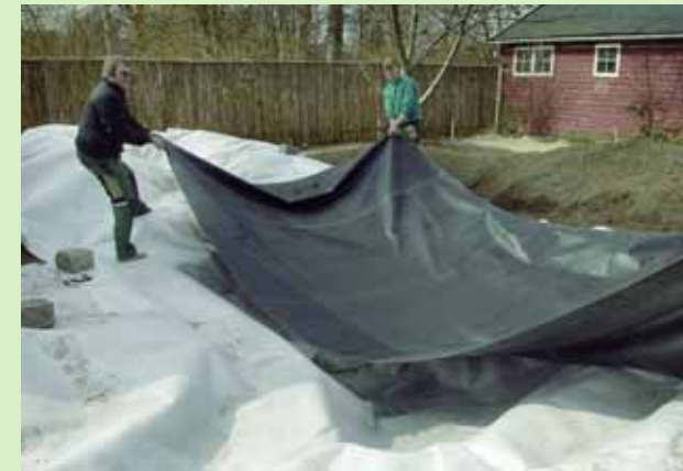
7. Gummidugen ilægges af flere mand, så geotekstilet ikke forskubber sig.
