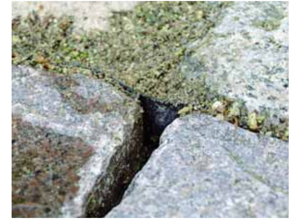
Gummidugen adskiller korrekt land fra vand, her med brostenskant.
