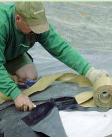
4. Den øverste dug sammenføjes, således at der fremkommer ca. 1 cm synligt EPDM-bånd. Båndet er forsynet med et lag beskyttende papir på oversiden.
