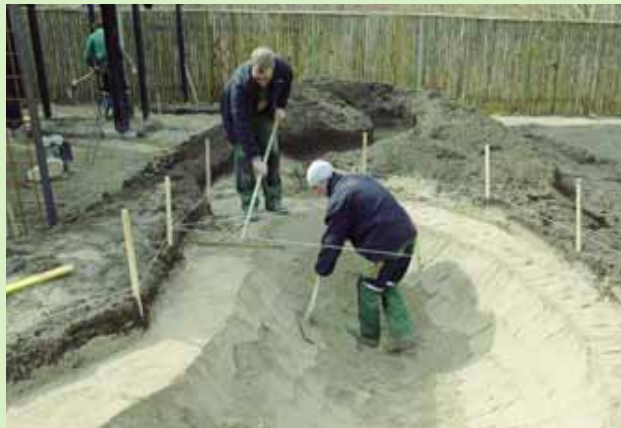
5. Gruset komprimeres og nivelleres meget omhyggeligt.
